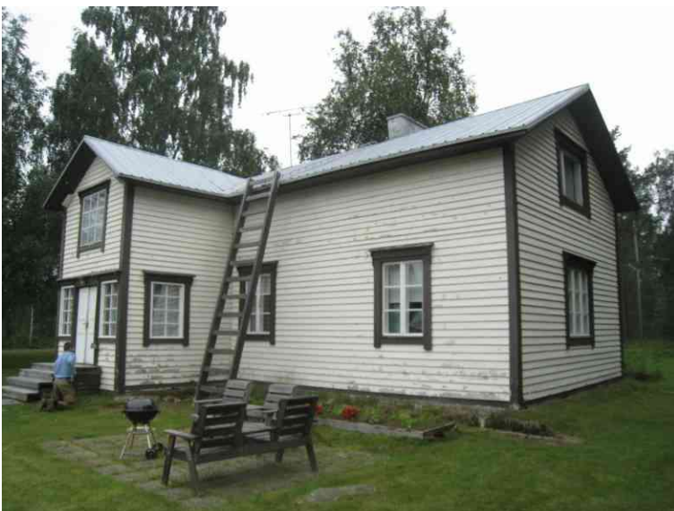
Kuva 3 Maan pinta rakennuksen vierustalla on suora.
