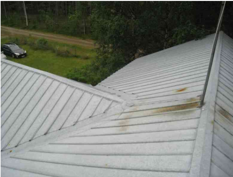
Kuva 5 Katepelti on kunnossa.
