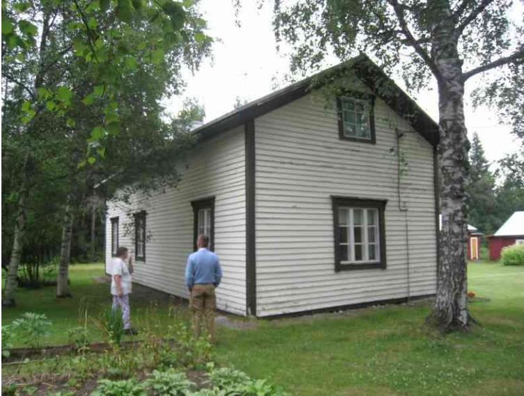
Kuva 1 Rakennus on hirsirunkoinen ja puuverhottu.
