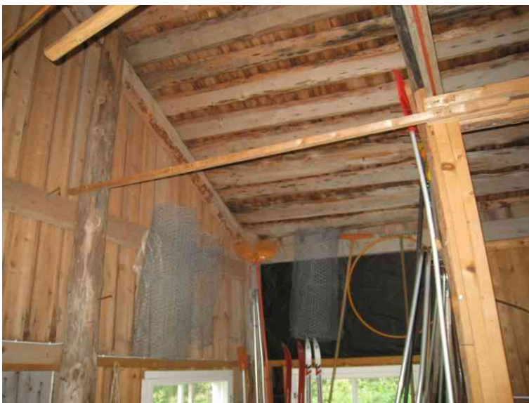
Kuva 15 Rak 2 :n vesikaton rakenteita.
