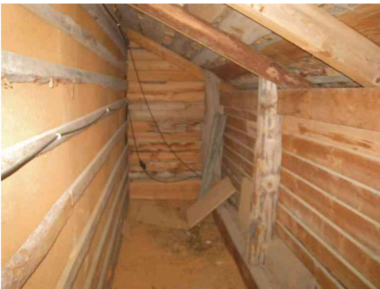
Kuva 6 Reunauhallakolla rakenteet ovat kuivat.
