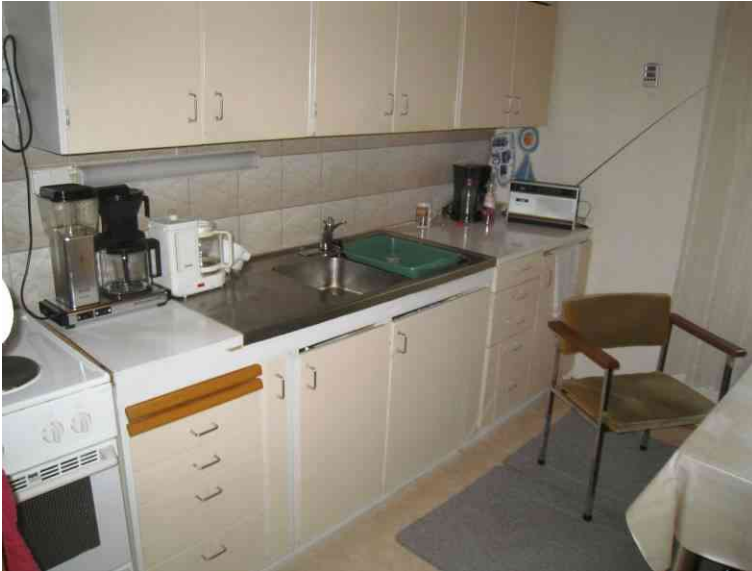
Kuva 17 Keittiön pinnat ovat kuivat. Kalusteet ovat käyttökunnossa.
