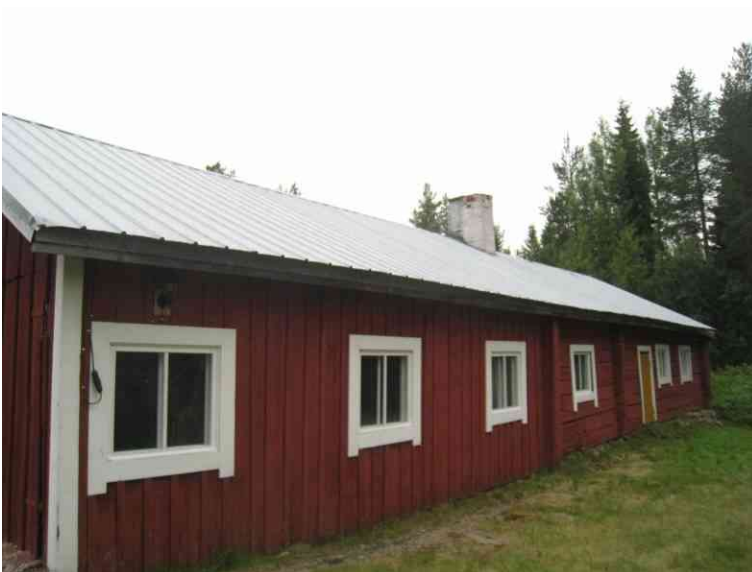
Kuva 27 Rak 3 :n takasivua. Oikea pääty on hirsirakenteinen.
