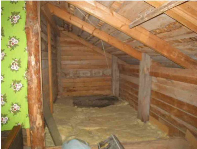
Kuva 10 Oh :n kohdalla on lisälämmöneristetty villalla.
