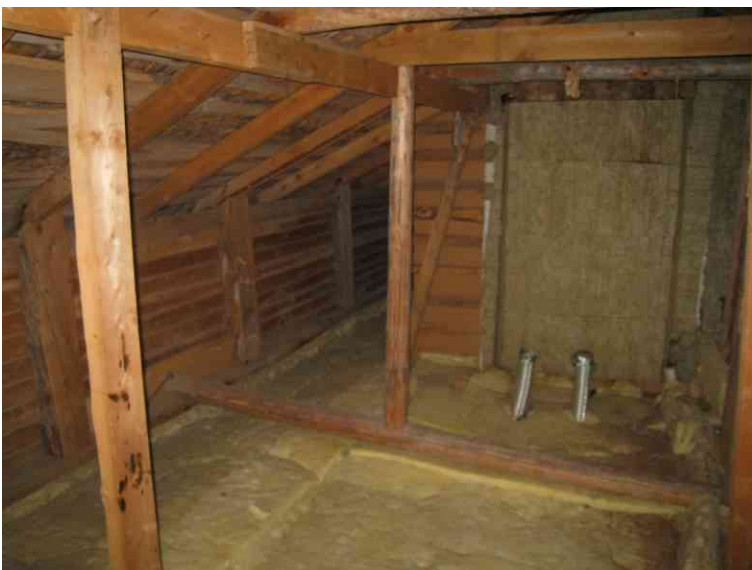
Kuva 9 Toisen päädyn ullakkoa. Iv-piippuja on johdettu ullakolle.
